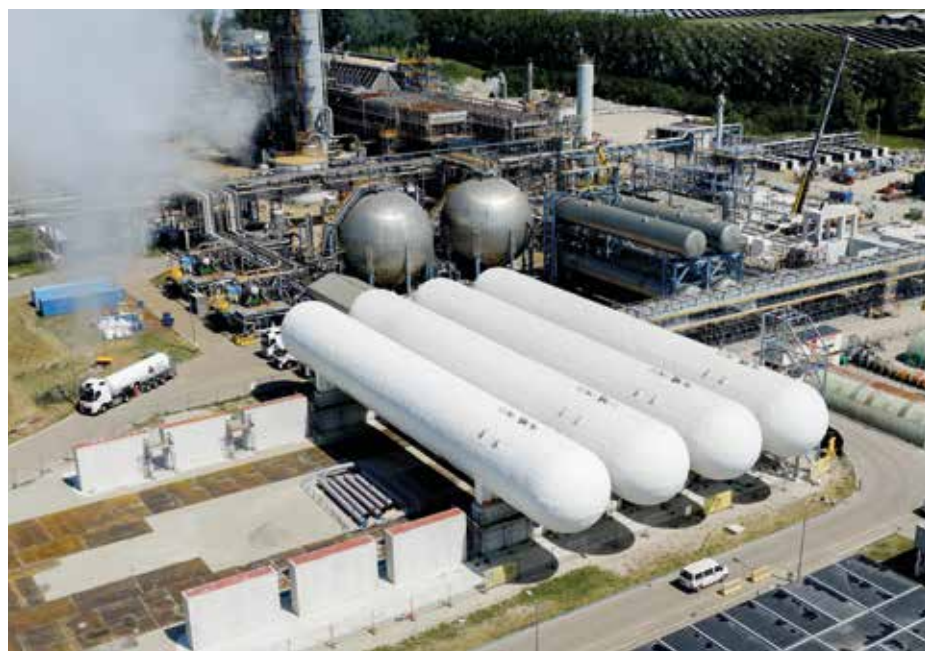
Storagetanks voor het CCS-project.
