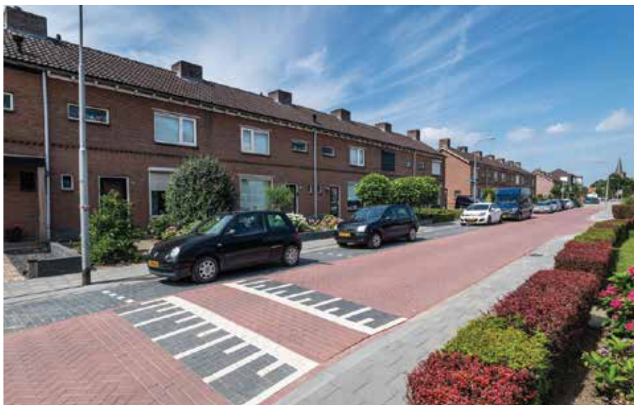
AquaBASE is een wegebouw constructie om wateroverlast in woonwijken te voorkomen en daarbij wordt Drainmix als een waterbergende en -passerende secundaire funderingslaag gebruikt onder wegverharding. Straten komen zo minder snel blank te staan bij extreme regenval.
