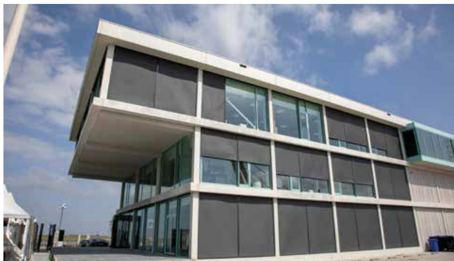
Kantoordeel nieuwe pand.
